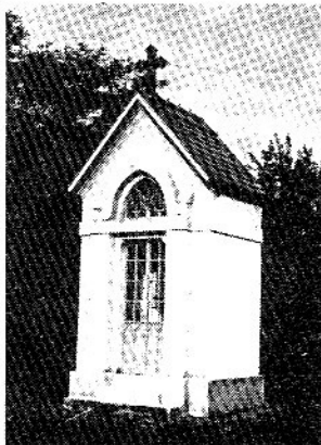
Eine der renovierten Kapellen am Kalvarienberg.
