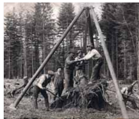
Mit dieser Maschine zogen die Holzhacker Baumwurzeln aus der Erde
