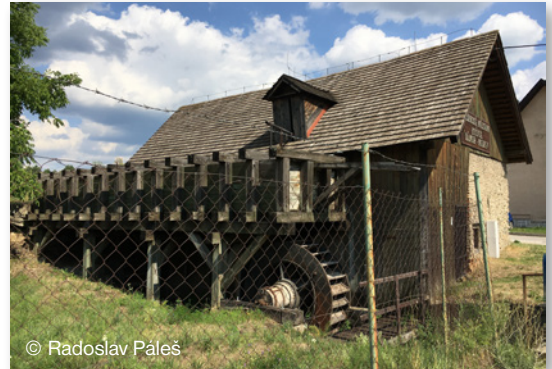
Die Wasserschmiede mit ihrem Antrieb
